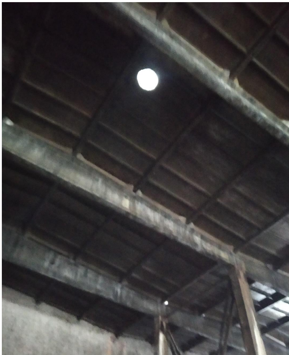
Рисунок 4.1 — Существующая система естественной вентиляции макулатурного цеха
