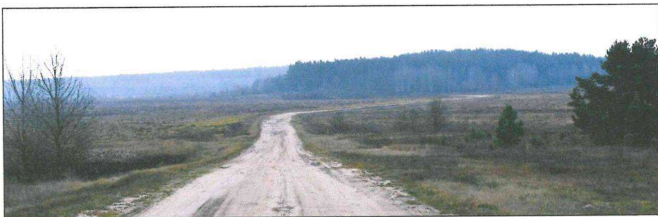
Рисунок 2.5 – Внутрихозяйственная автомобильная дорога, проходящая южнее участка планируемой деятельности (ноябрь 2025 г.)
