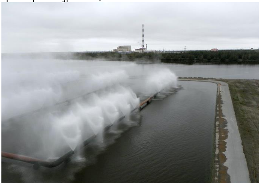
Рисунок 2.15 – Охладительный канал и бассейн Минской ТЭЦ-5
